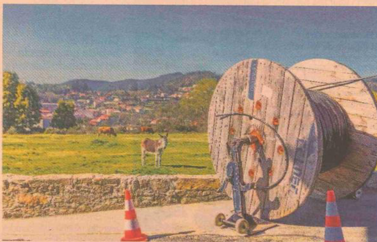
Imagen que muestra la primera fase de despliegue de fibra óptica por Aurea en Ponte Caldelas.
